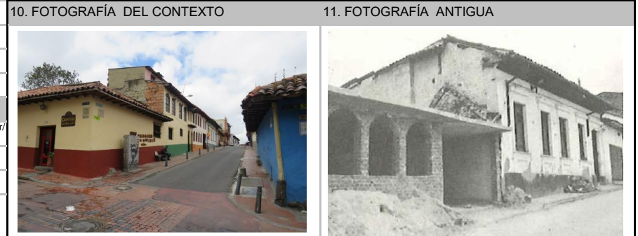
Fuente: Equipo Fotografía PEMP Patrimonio Inmueble Fuente: Inmueble de 1 piso paramentado en un predio medianero de forma gular, cuyas dimensiones son:
